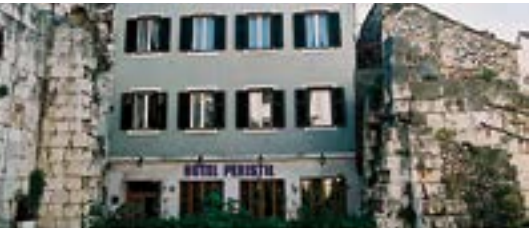
Hotel Peristil Split (Croazia)
