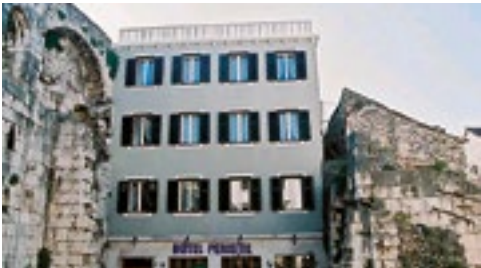
Hotel Peristil Split (Croazia)
